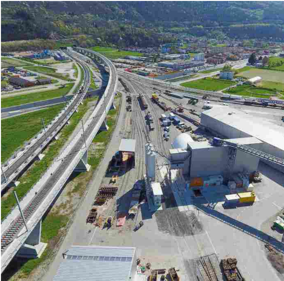
Il cantiere sul lato settentrionale della galleria del Ceneri
