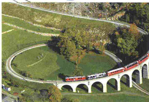
Foto sopra: il viadotto elicoidale di Brusio
