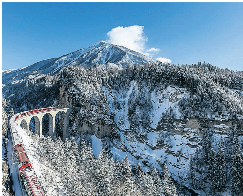
Un voyage de tunnels en viaducs : une expérience inoubliable !
