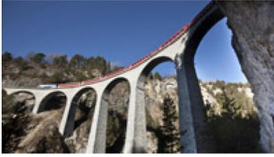
Zu den weltweit bekanntesten Wahrzeichen der Rhätischen Bahn zählt das **Landwasserviadukt** bei Filisur. Es führt über das Landwassertal direkt in einen Bergtunnel. Ohne Gerüst mit zwei Kränen erbaut, war die Konstruktion der drei Hauptpfeiler in den Jahren 1901/02 ein architektonisches Glanzstück.
